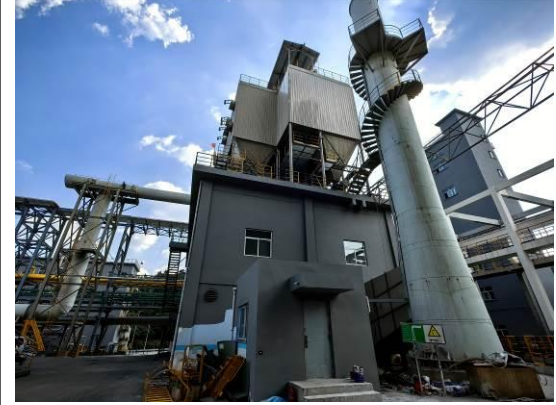
装煤推焦机侧地面除尘站排放口
