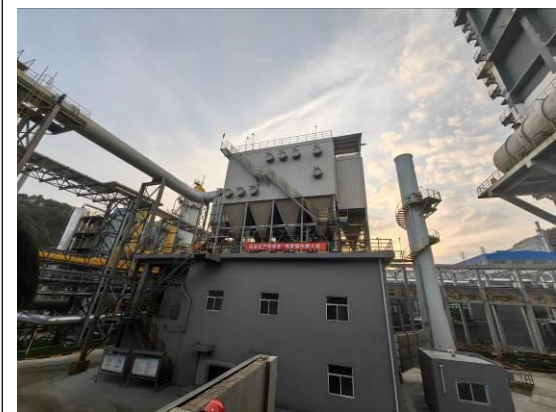
装煤推焦机侧地面除尘站排放口
