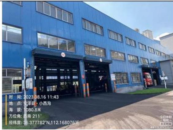
汽车受煤坑北侧东门
