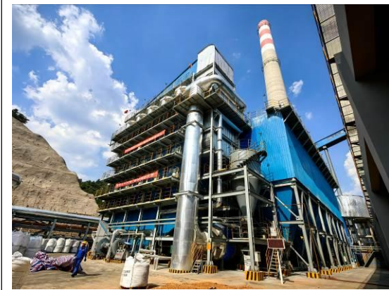
焦炉烟气脱硫脱硝排放口
