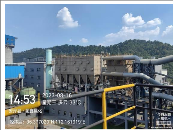
干熄焦地面除尘站排放口
