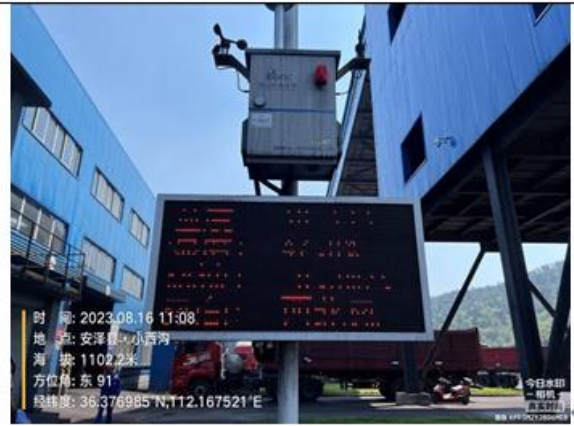
汽车受煤坑南侧西门
