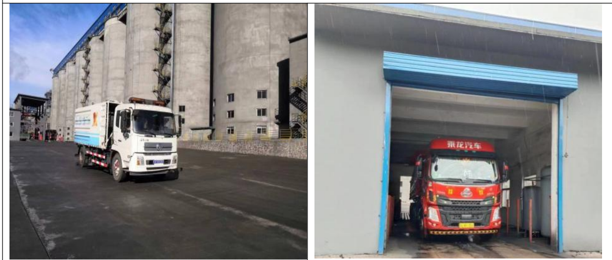
厂区道路及洗车平台
