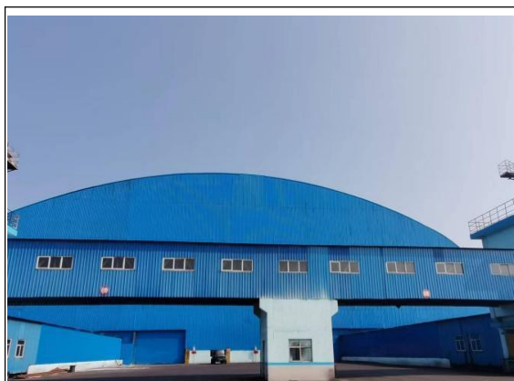
煤 3#皮带全封闭通廊
