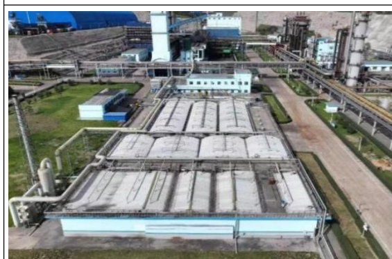
污水站废气加盖收集
