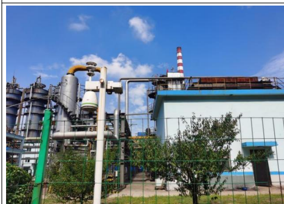
厂区东侧杆式空气质量监测仪
