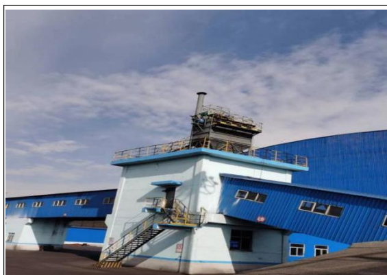
精煤转运除尘器 3#
