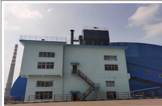
精煤预破碎除尘器
