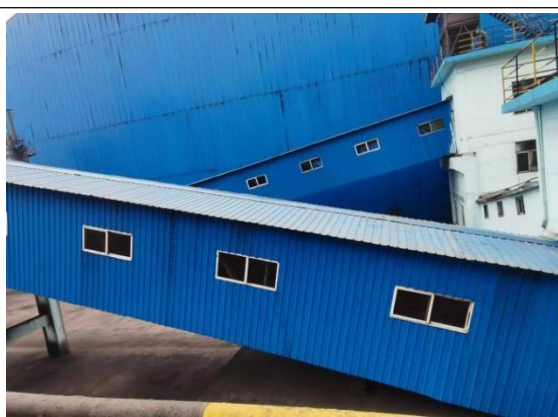
煤 6#皮带全封闭通廊
