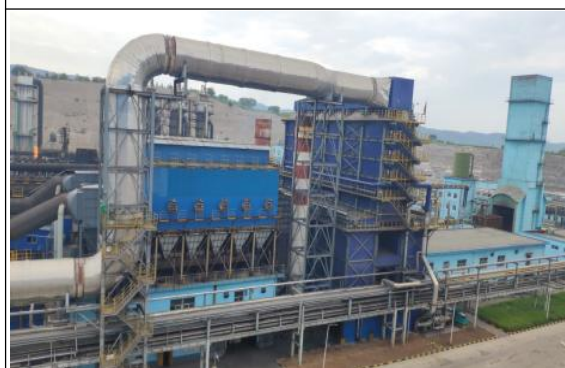
焦炉烟气除尘脱硝系统
