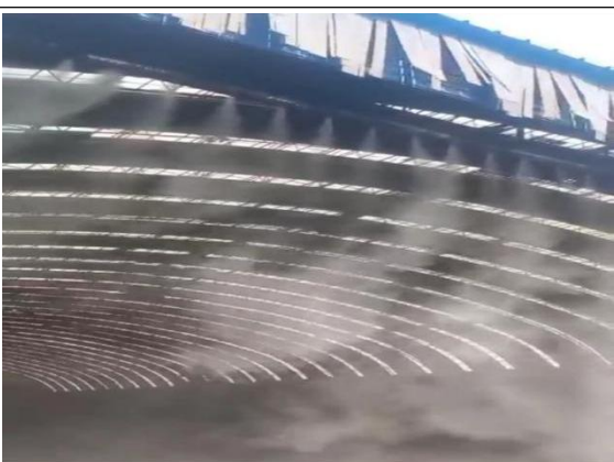
二期焦化煤棚雾帘
