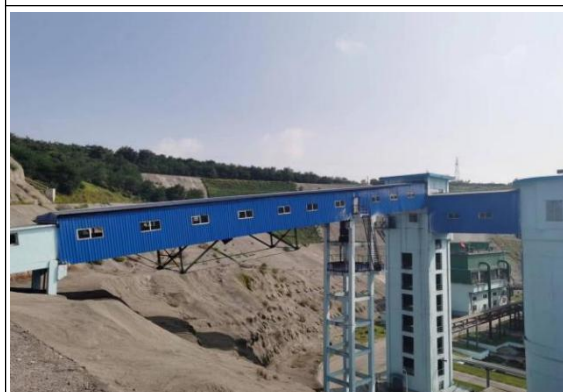
煤 8#皮带全封闭通廊
