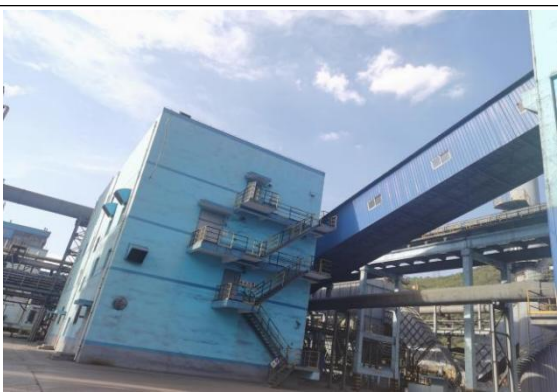
备 2 皮带全封闭通廊
