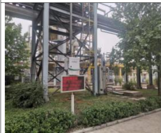
二回收西南PM 10 监测微站
