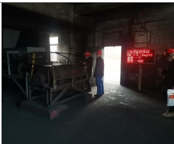
一系精煤破碎机落料点 TSP 监测仪
