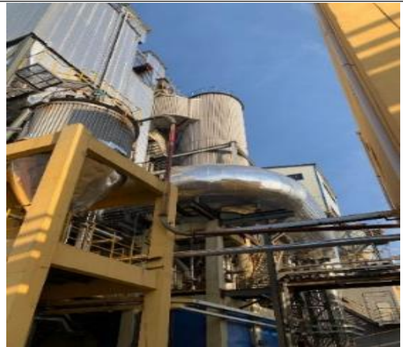
4#焦炉烟气脱硫脱硝装置
