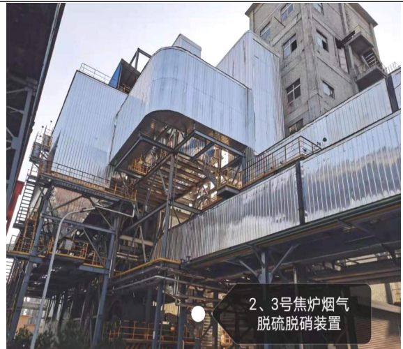
2#、3#焦炉烟气脱硫脱硝装置
