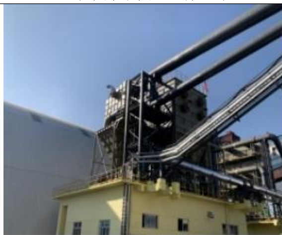
一系干熄焦地面除尘站
