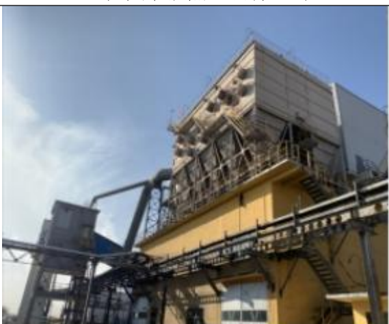
二系干熄焦地面除尘站
