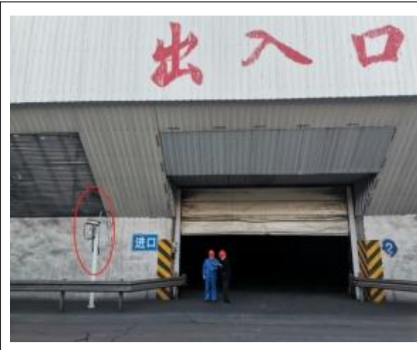
储煤场北侧进口视频监控装置
