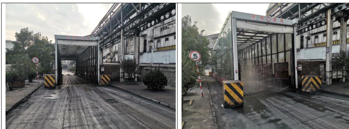
全厂储煤场出口洗车平台
