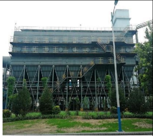
二期焦仓除尘器
