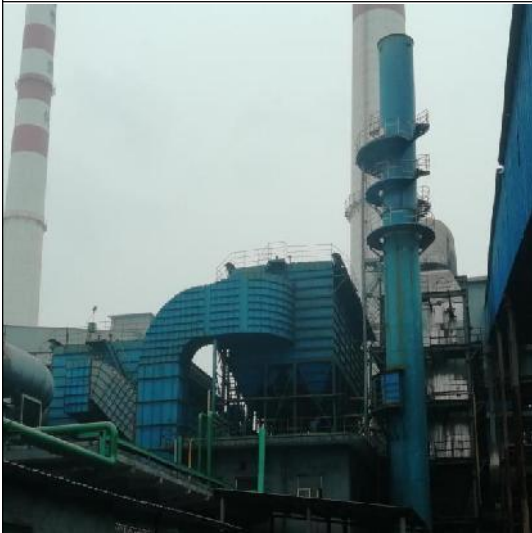
1#焦炉装煤推焦地面站
