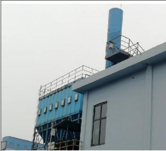
一期粉碎机除尘器
