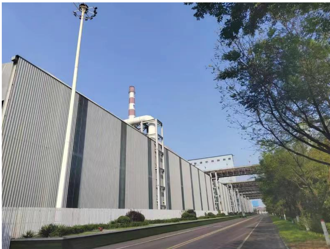
一期焦炉机侧封闭
