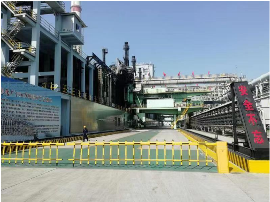
二期一炼焦设备及全不锈钢美化的焦炉机侧
