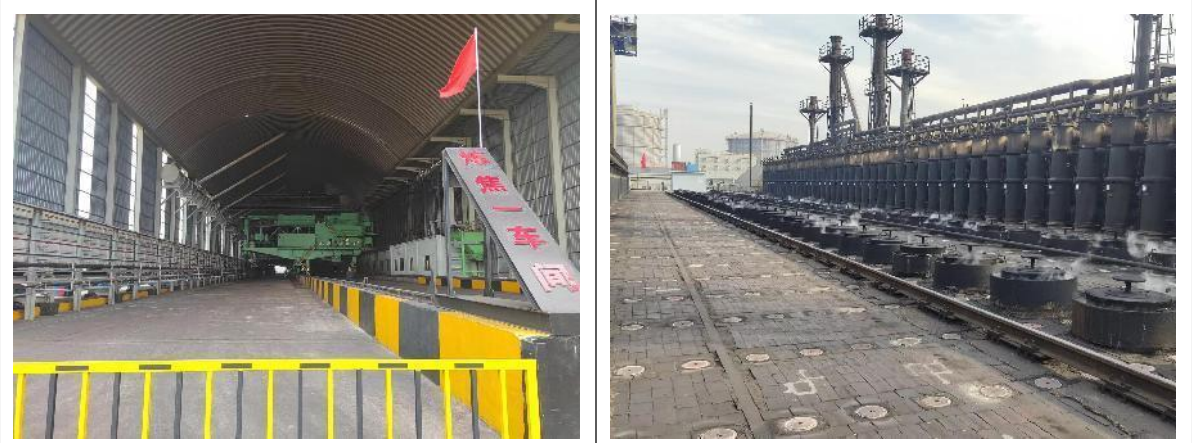
一期焦炉及炉顶
