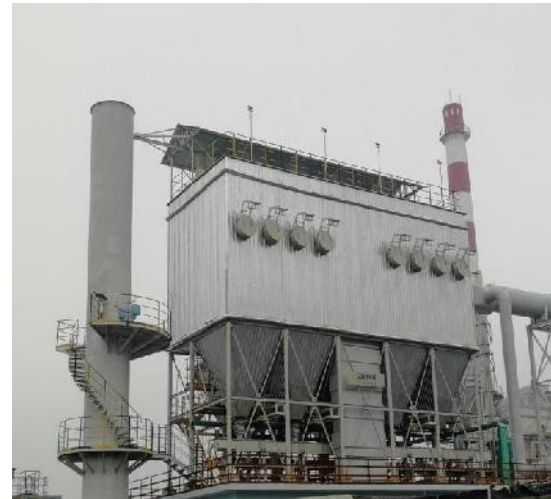
4#机侧平煤除尘器
