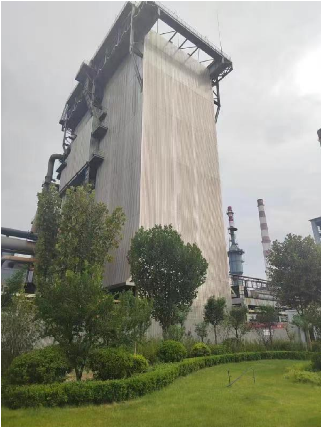
二期封闭干熄焦及厂区花园式绿化
