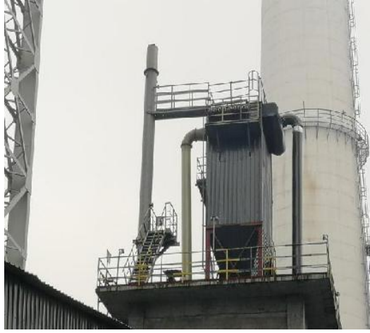
湿熄焦 C202 除尘器
