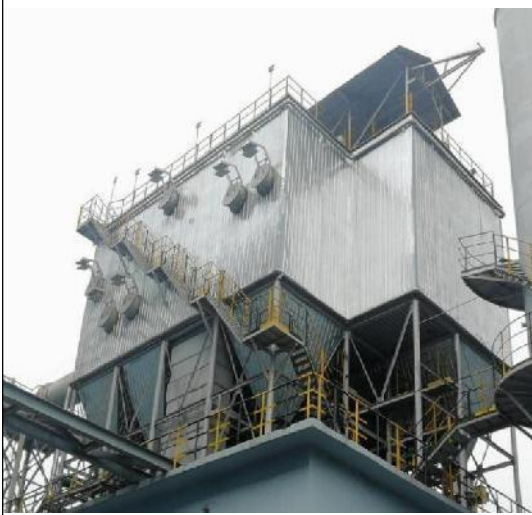
3#机侧平煤除尘器
