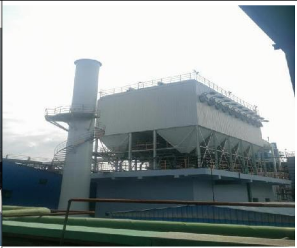
1#机侧炉头烟除尘器
