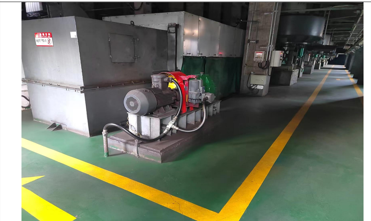
落料点封闭并配套负压收尘措施
