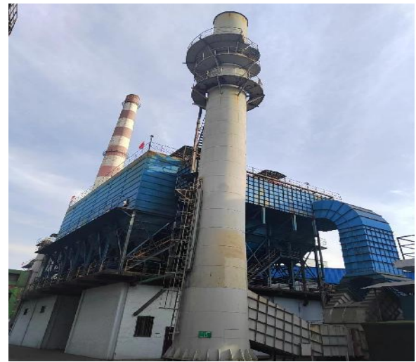
2#焦炉装煤推焦地面站
