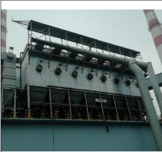
3#焦侧装煤除尘器
