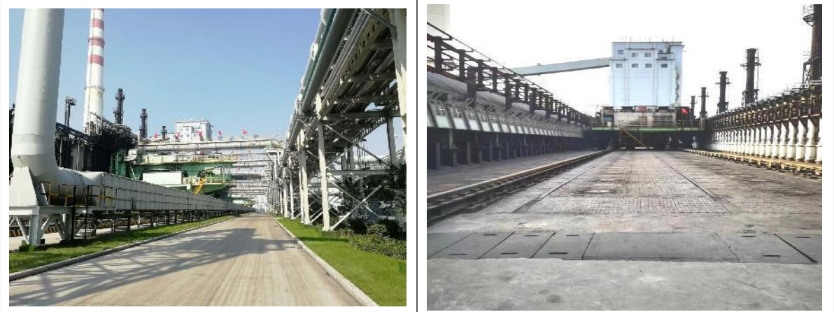
二期焦炉及炉顶
