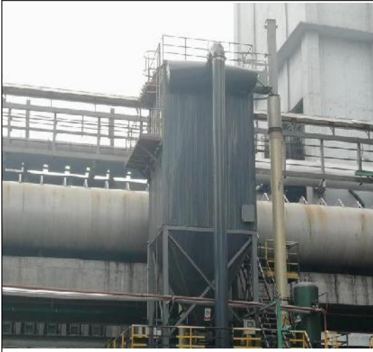
湿熄焦 C201 除尘器
