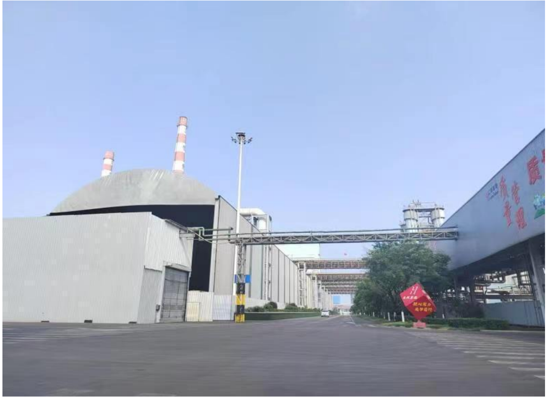
一期焦炉封闭
