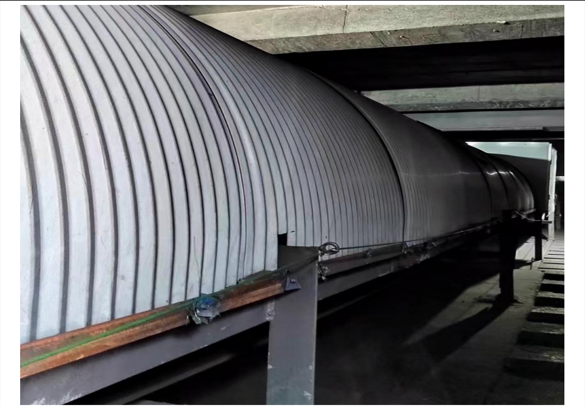
封闭皮带走廊
