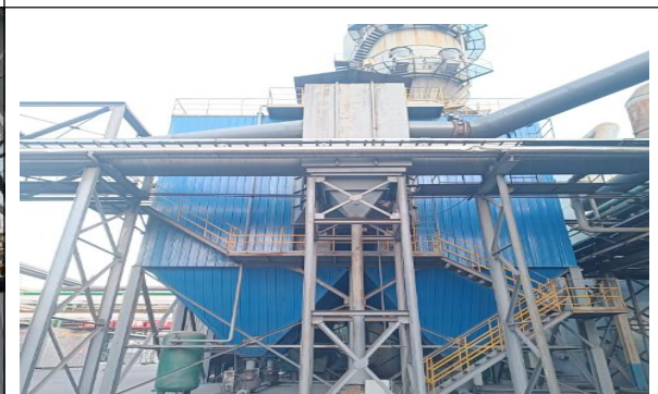
干熄焦脱硫塔除尘器
