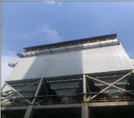
一期焦炉烟气脱硫除尘器
