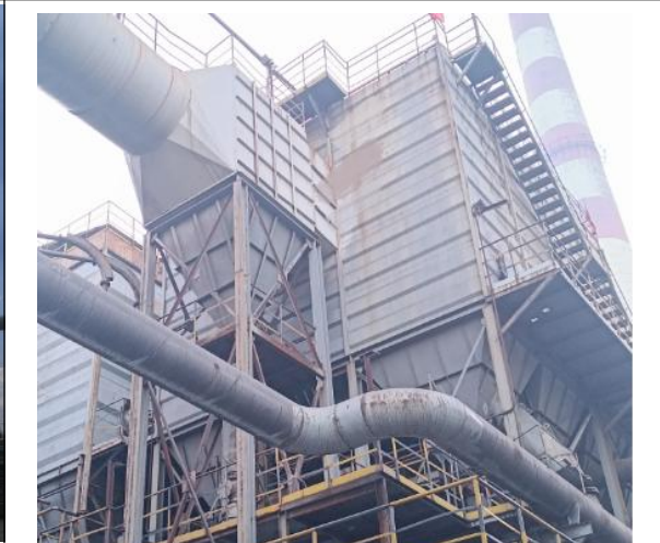
一期干熄焦环境除尘器
