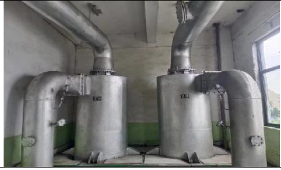
一期硫铵除尘系统
