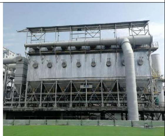
4#焦侧装煤除尘器
