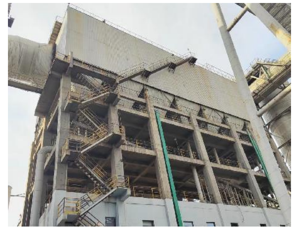
二期焦炉烟气脱硫除尘器
