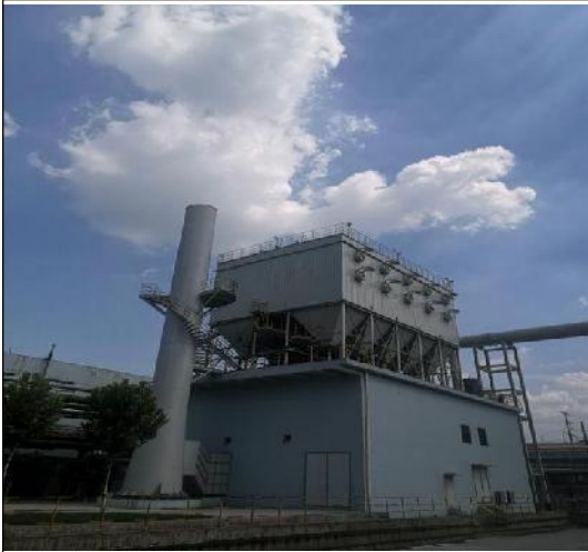
2#机侧炉头烟除尘器
