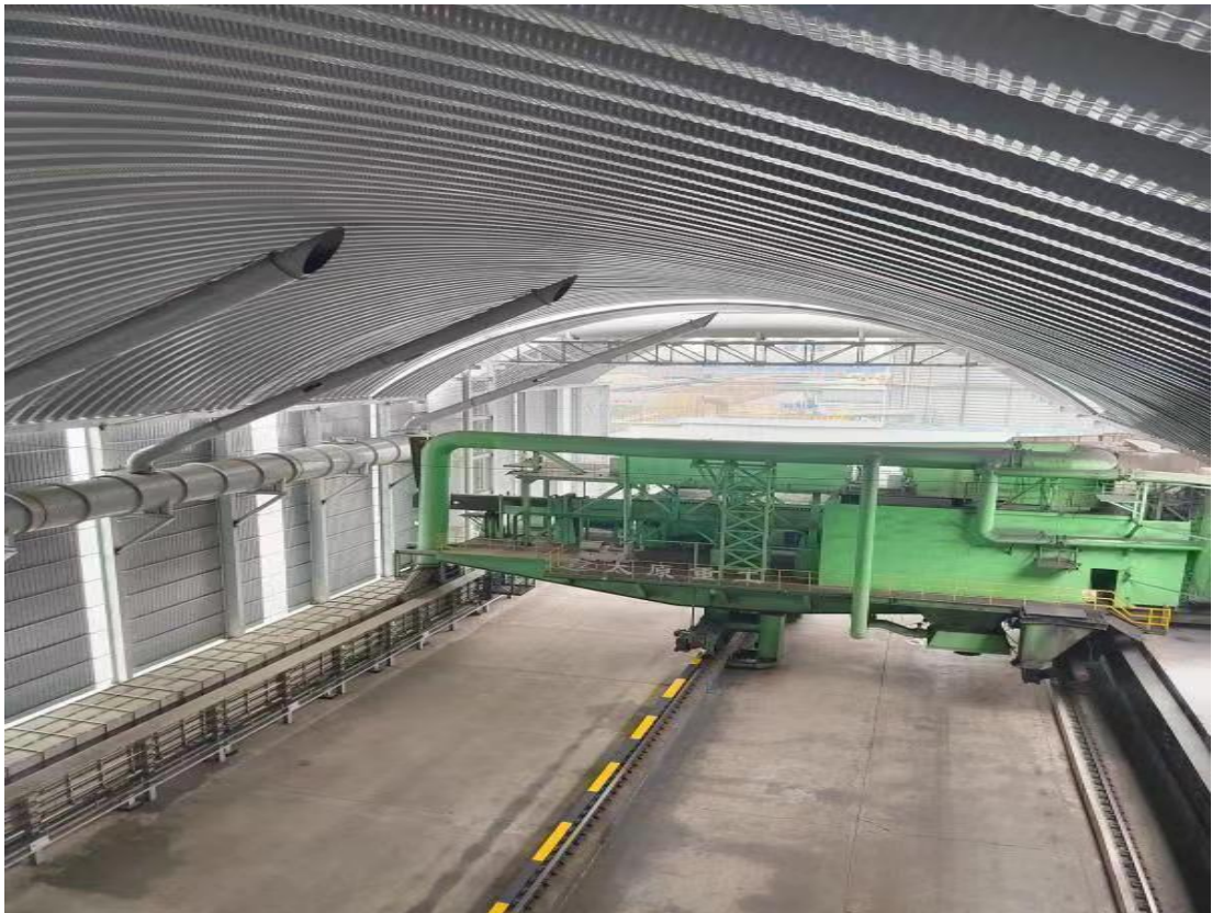
一期焦炉封闭内部
