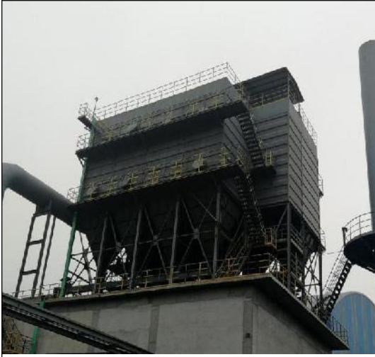
二期受煤坑除尘器
